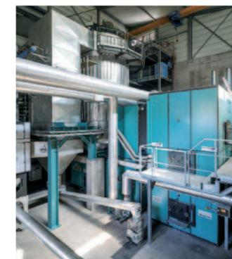
Die Holzfeuerungsanlage mit nachgeschaltetem Thermoölkessel.
