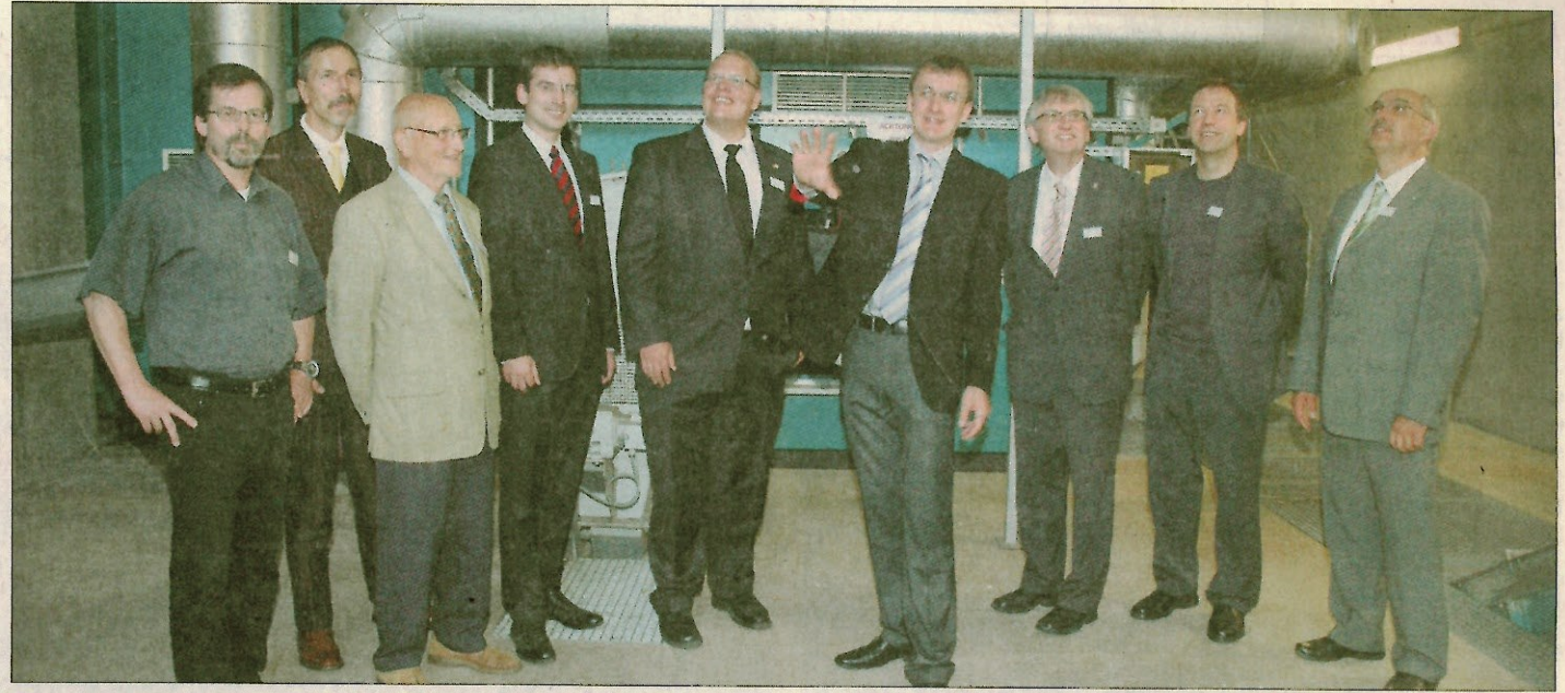
Besuch im Herzstück des Biomassekraftwerks in Nordrach: von links Klinikmanager Ulrich Ehret von der Rehaklinik Klausenbach, die Sägewerks-Gesellschafter Herbert Bruder und Wilhelm Oberle, Erster Landesbeamter Nikolas Stoermer, Bürgermeister Carsten Erhardt, Sägewerks-Geschäftsführer Manuel Echte, Regierungspräsident Julian Würtenberger, Landtagsabgeordneter Thomas Marwein und Professor Bastian Kaiser, der einen Vortrag zum Thema »alternativlose Alternativen« hielt. Foto: Dietmar Ruh
