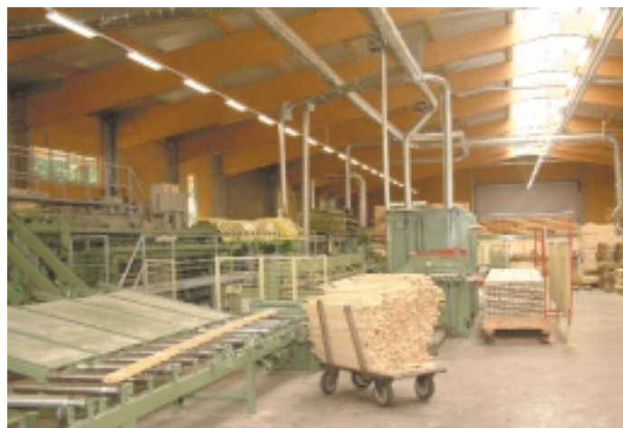
Seit Jänner in Betrieb: Die Hobelstraße von Weinig in der neuen 3000 m 2 -Halle
