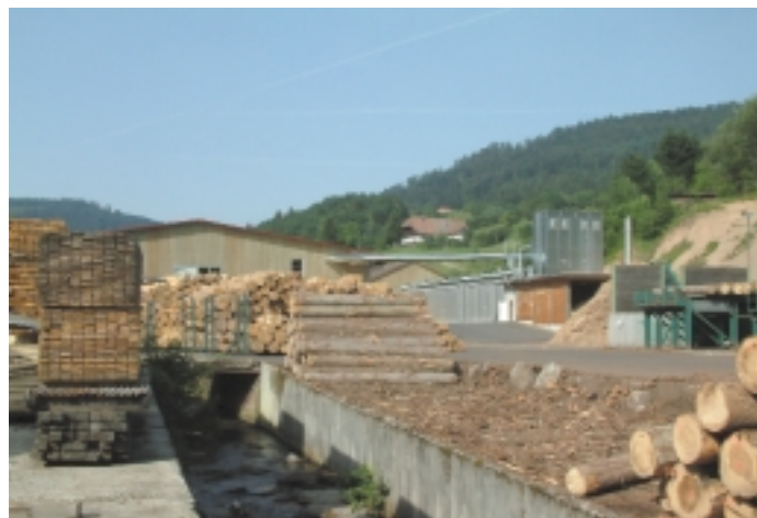
Früher Energiequelle: Der Bach teilt Schnitt- und Rundholzplatz mit Entrindung rechts, Trockenkammern und Hobelwerk im Hintergrund
